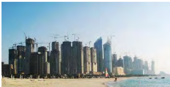
* 建築工程用之起重機吊架隨處可見 *
